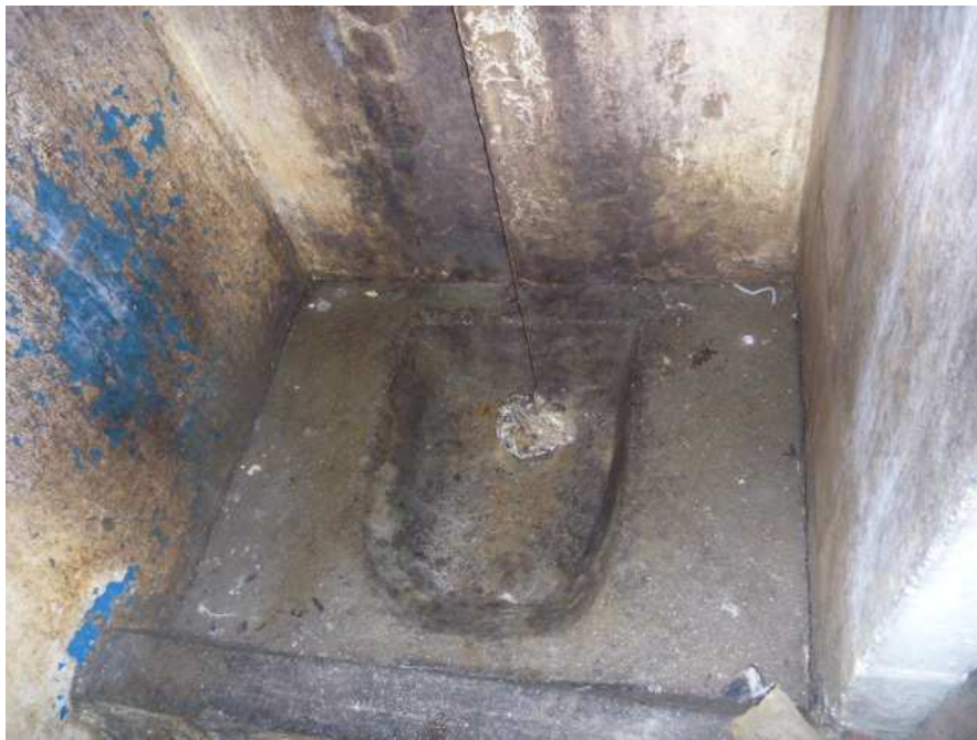
Sanitário de cela – Presídio Santa Augusta de Criciúma
